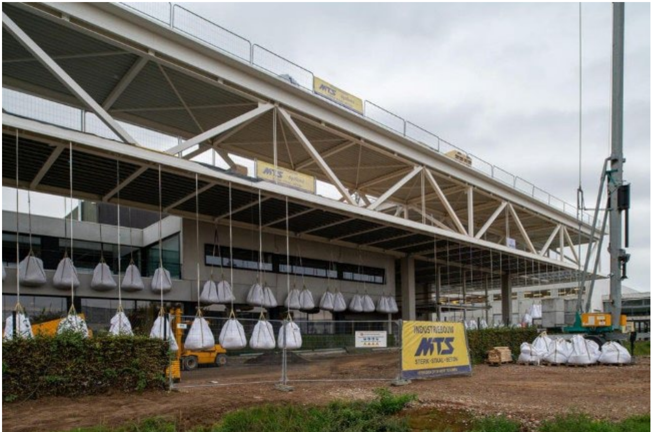
Bigbags met zand simuleren het gewicht van de glazen gevel. — © rr
