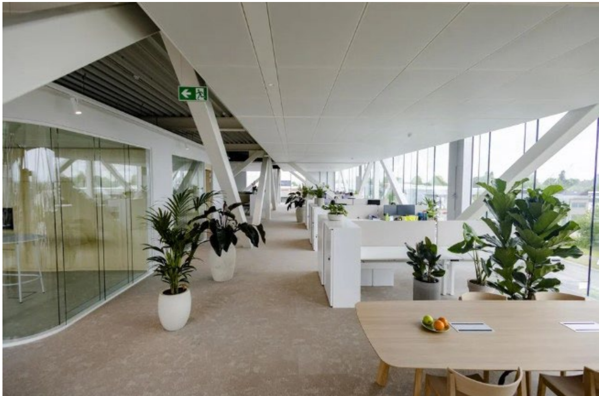
Klimaatpafonds zorgen voor verwarming en koeling. — © Tom Palmaers
